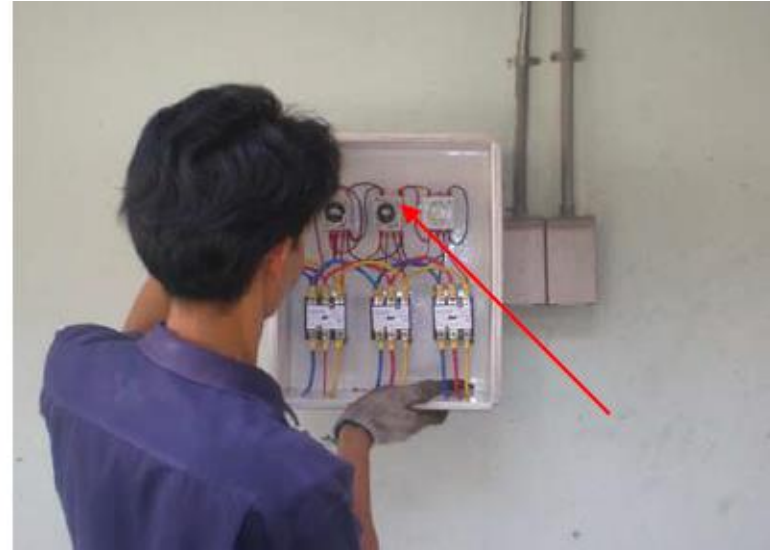
การติดตั้งสวิตช์ เปิด-ปิด อัตโนมัติ
