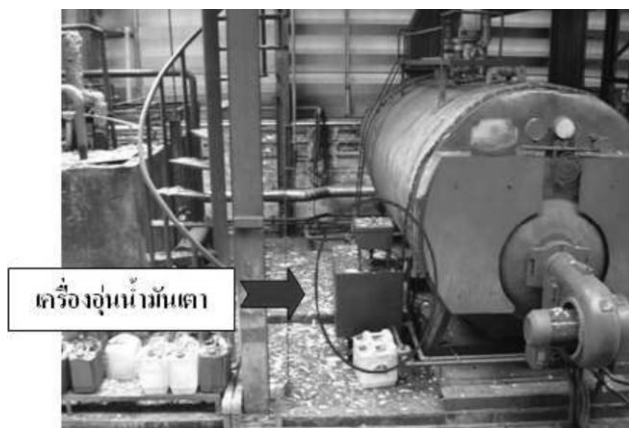
รูปที่ 2.13 เครื่องรีบน้ำมันเตาที่ได้รับการดัดแปลงให้สามารถผสมกับน้ำมันเครื่องใช้แล้วได้
