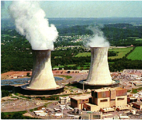
แบบ natural draft counter flow
