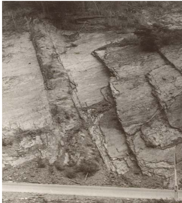
รูปที่ 9.1 การวิบัติแบบระนาบบริเวณเส้นทางหล่มสัก – ชุมแพ (จาก Wannakao et al., 1985)
