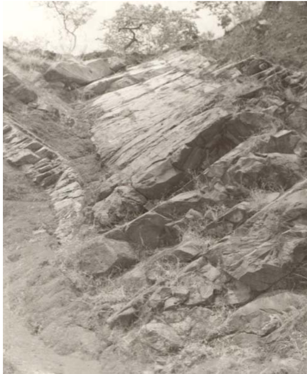
รูปที่ 9.2 การวิบัติแบบล้มบริเวณเส้นทางหล่มสัก – ชุมแพ (จาก Wannakao et al., 1985)
